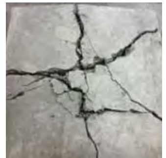
Losas de hormigón cuadradas, de 600 x 600 mm, sometidas a un ensayo de carga concentrada según la norma EN 14488-5
